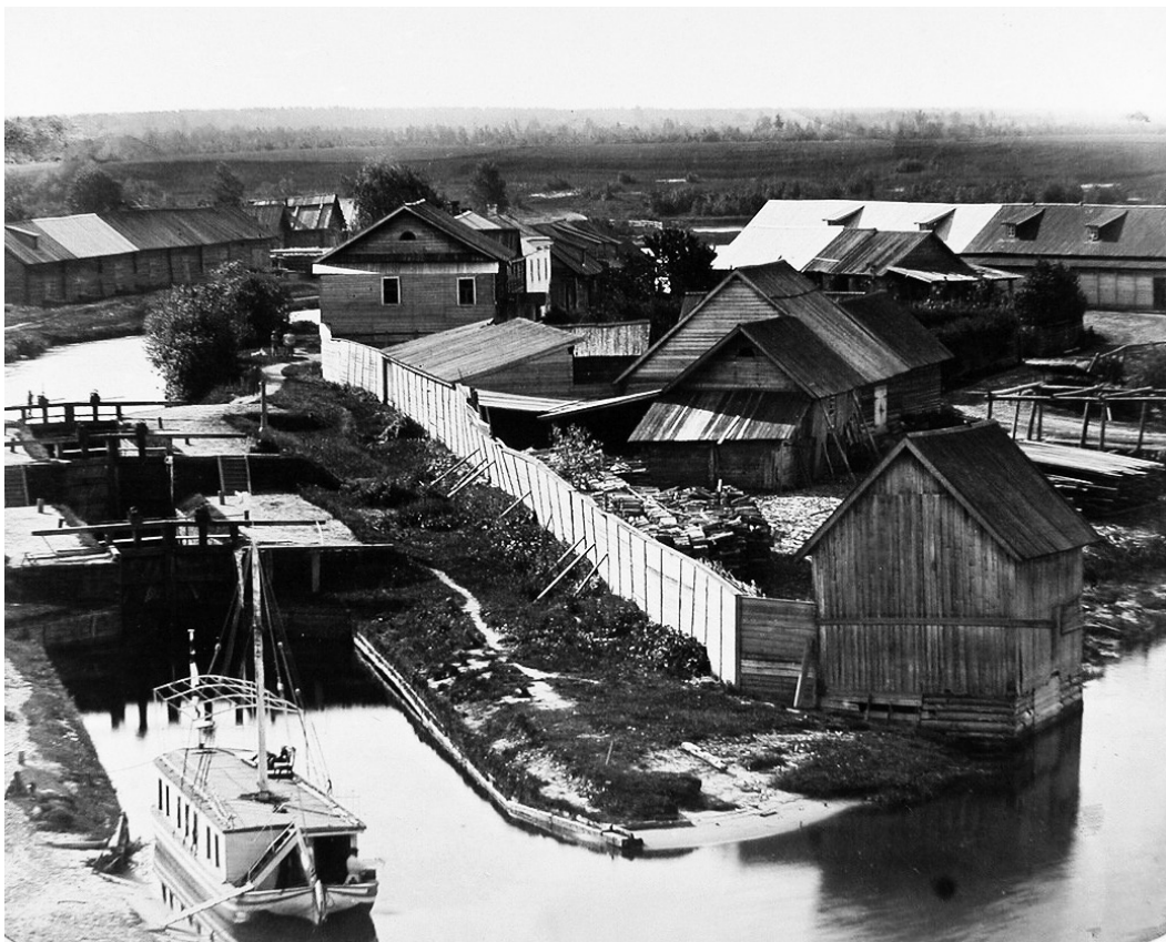
Вид с горы на Новгородский шлюз
