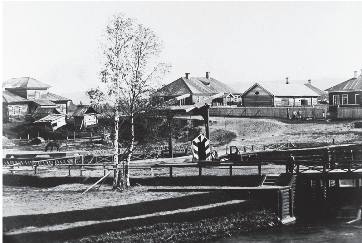
Вид на Шлиссельбургскую плотину и шлюз, в центре на втором плане - дом начальника дистанции
