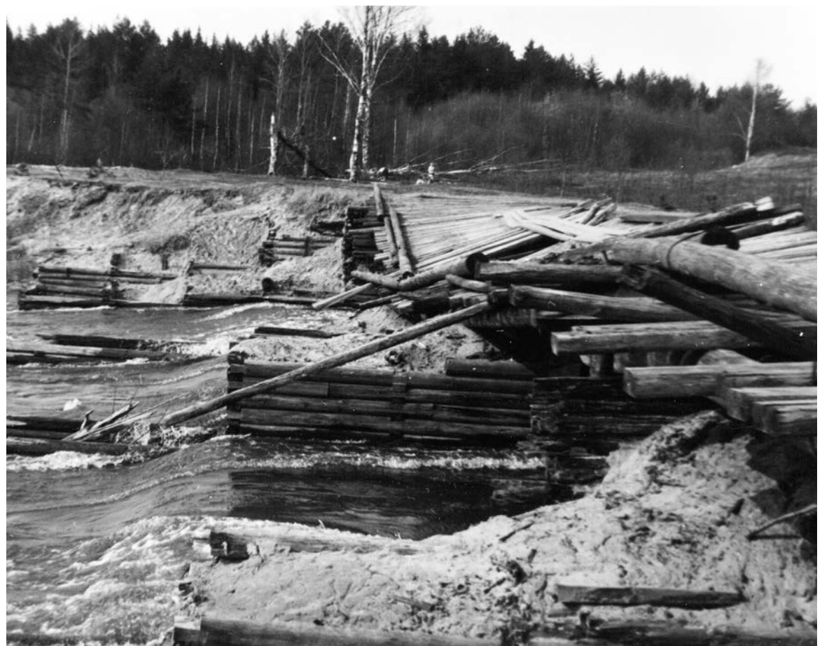
Полуразрушенная плотина Харьковского шлюза на реке Тихвинке к востоку от деревни Астрачи. Фото 1974 года.
