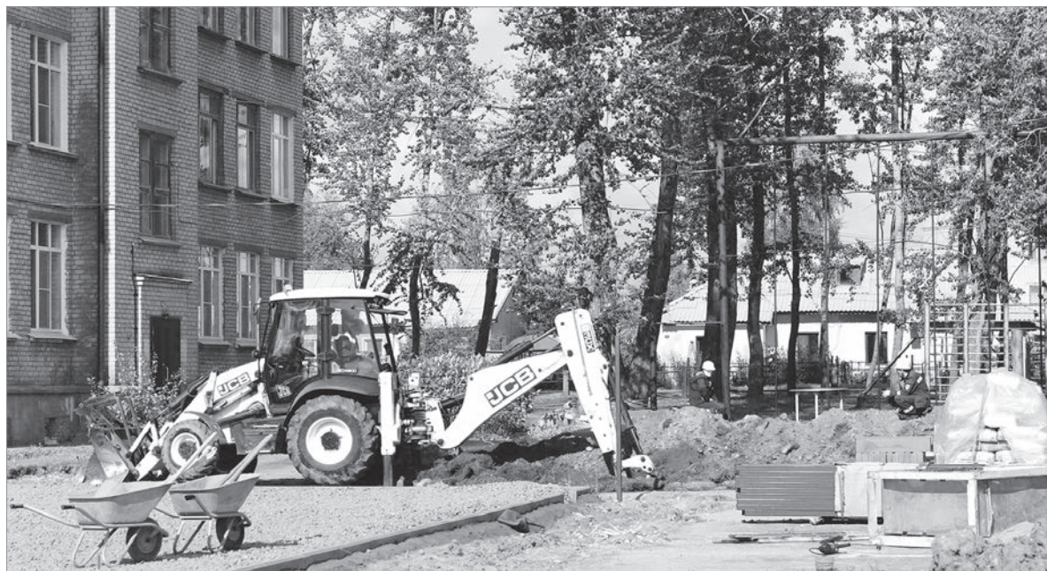
В школе №1 идёт строительство спортивной площадки
