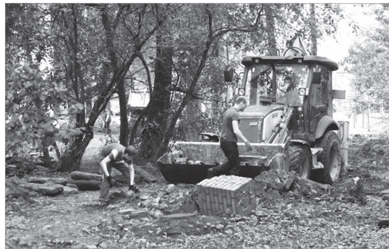
Строится новое ограждение вокруг здания школы №2
