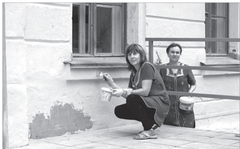
Ремонт фасада школы №2
