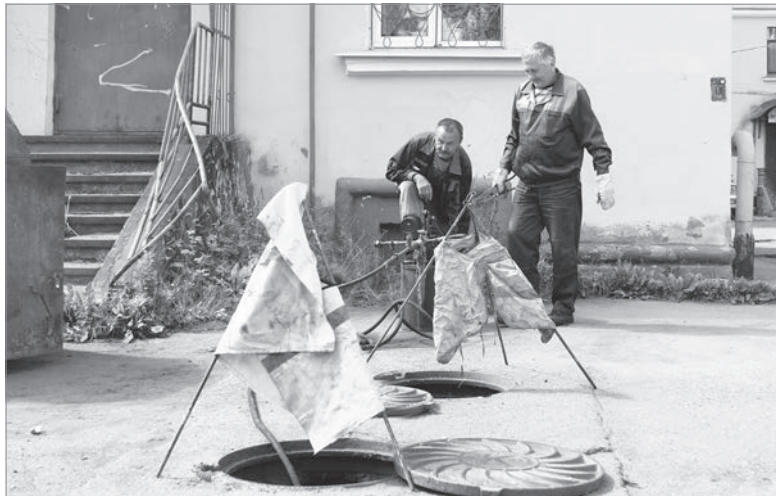
Идут гидравлические испытания квартально-тепловых сетей
