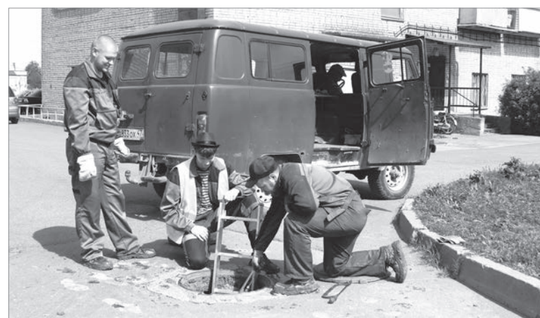
Работники АО «Пикалевские тепловые сети» делают ревизию запорной арматуры
