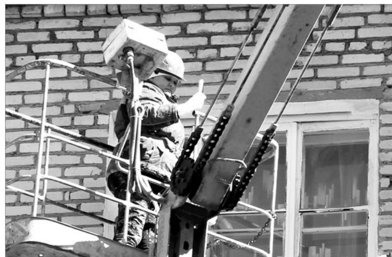
Ремонт фасада дома №2 на улице Спортивной
