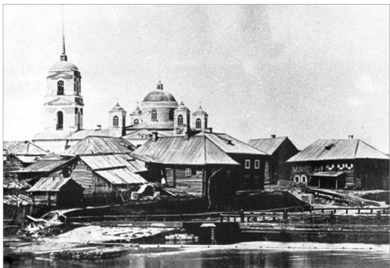
Шлиссельбургский шлюз и Михайловская церковь в Озерах. Фото 1865 г.
