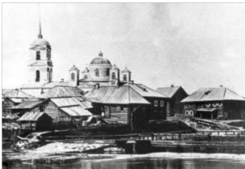
Шлиссельбургский шлюз и Михайловская церковь в Озерах. Фото 1865 г.
