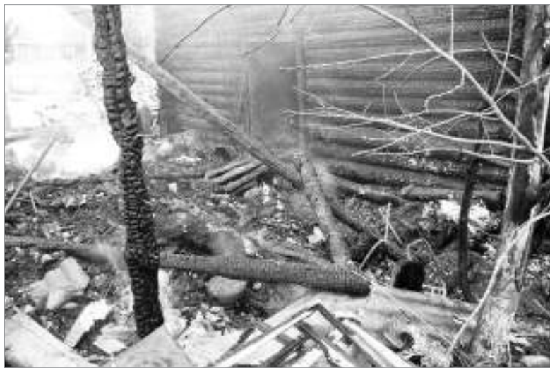
В д. Заголодно в доме 26 пятого апреля произошёл пожар в частном жилом доме. На пожаре погибло два человека – мужчина и женщина – без видимых причин насильственной смерти. В данный момент причина пожара устанавливается. Предварительная причина – нарушение требований пожарной безопасности.
