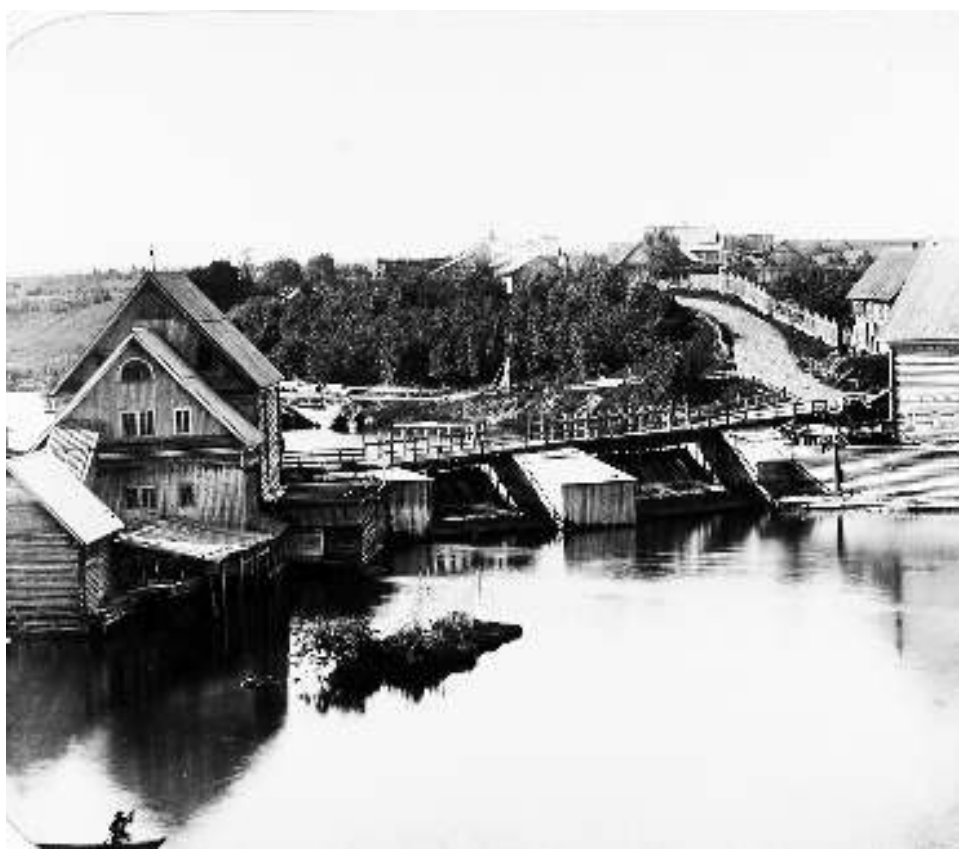
Вид на Новгородскую плотину и мукомольный завод
