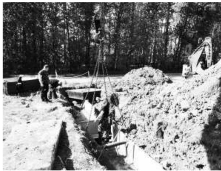
лотки меняются, так как новые трубы в ППУ-изоляции физически в них не помещаются. В ремонт выведены первая, вторая и часть третьей линии. Будет заменено более 2,5 километров трубы и 1,3 километра лотков. По окончании ремонтов будет проведено благоустройство с восстановлением тротуаров и дорог.
