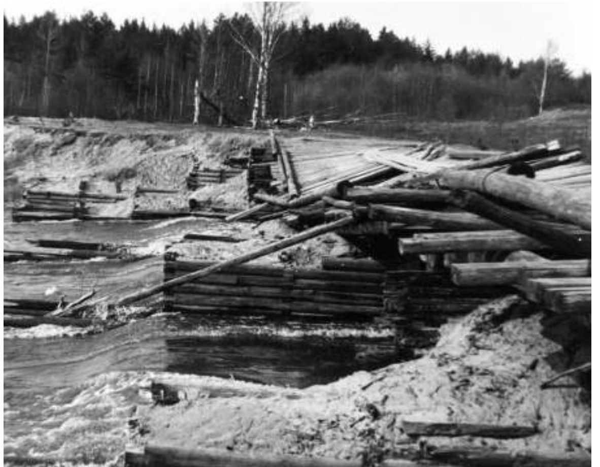
Полуразрушенная плотина Харьковского шлюза на реке Тихвинке к востоку от деревни Астрачи. Фото 1974 года.
