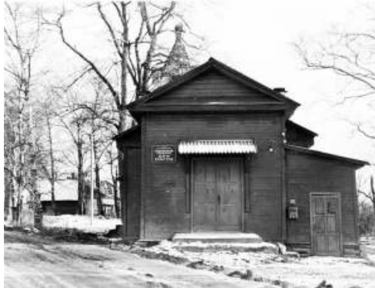
Сенновский сельский дом культуры в здании церкви во имя св. Флора и Лавра постройки 1883 года. Фото 1982 года.
