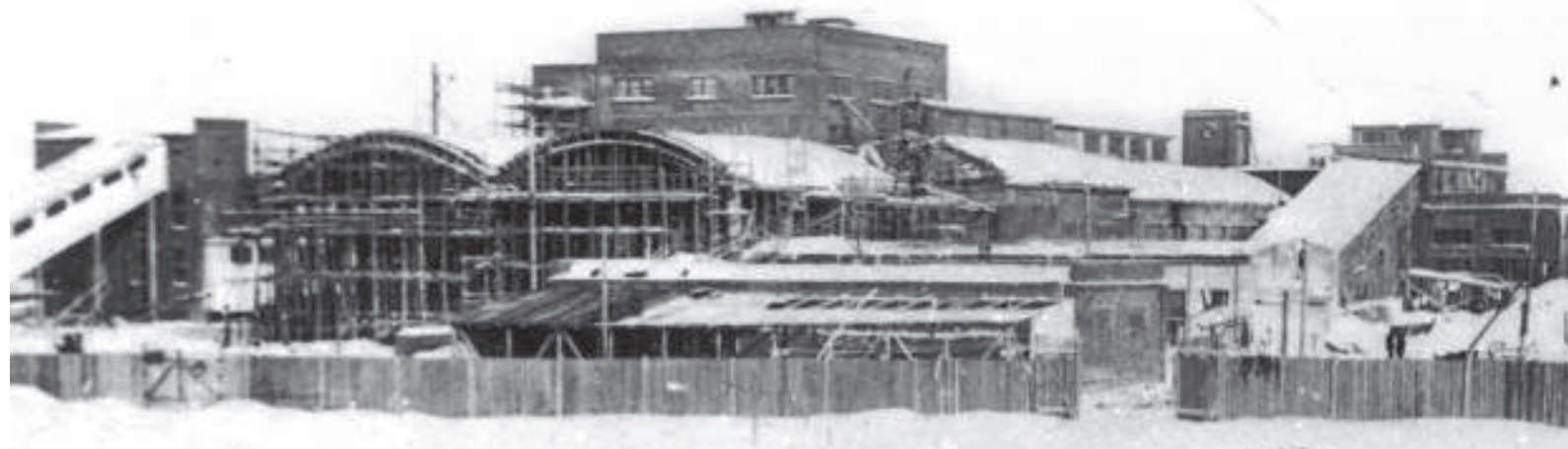
Пикалёвский цементный завод. 1940 (Из фонда Пикалёвского краеведческого музея)
