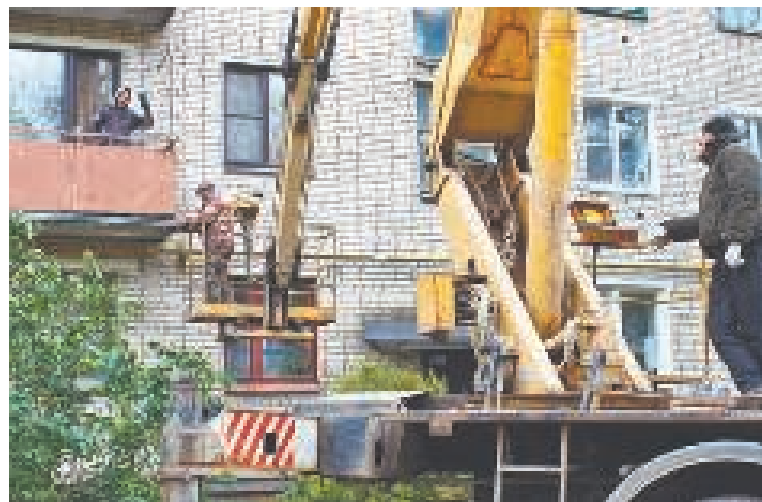
Ремонт балкона в доме № 37 в 6 м-не ведут кровельщики С.А. Кононов и В.М. Черняк
