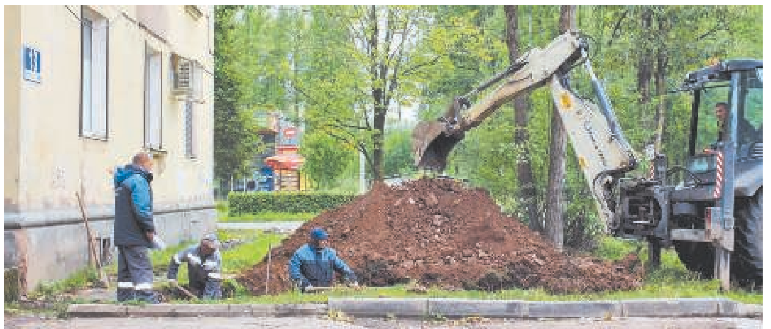
Бригада А.А. Грибаненкова устраняет протечку на трубопроводе на ул. Вокзальной, д.13.
