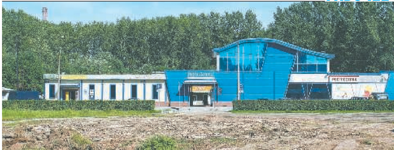
Напротив здания городского рынка строится площадка для городских ярмарок
