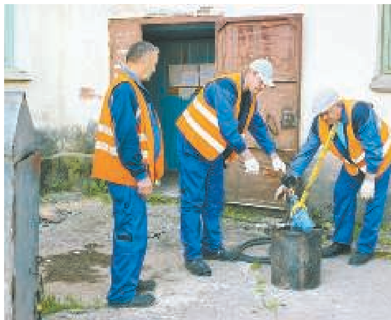
Гидравлические испытания тепловых сетей ведут слесари А.В. Малюшкин, А.Д. Мещанинов, С.В. Романенко.
