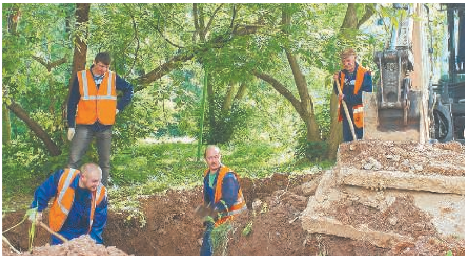
Устранение утечки теплоносителя на магистральном трубопроводе. Работают машинист экскаватора С.В. Ларькин, бригадир А.А. Грибаненков, слесари А.С. Зинков, В.А. Туманов, И.Г. Кривов.
